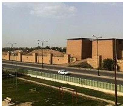
Puerta occidental reconstruida
